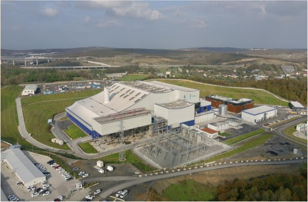
* Atık Yakma ve Enerji Üretim Tesisi
