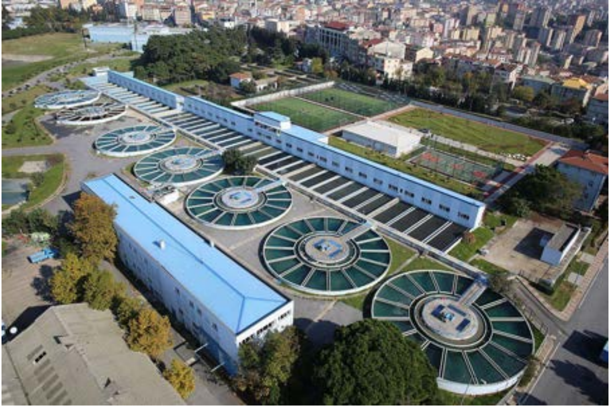
Atık Su Arıtma Tesisi
