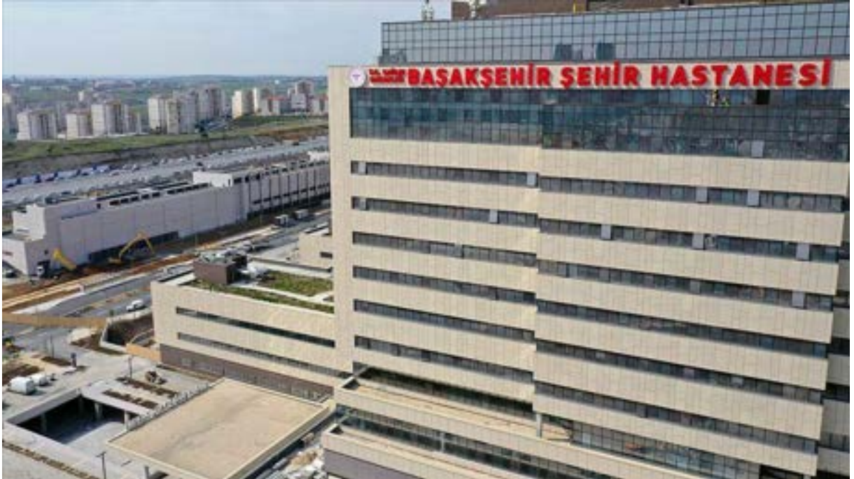
Başakşehir Şehir Hastanesi
