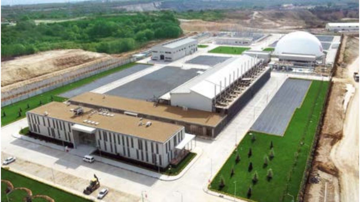
Çöp Gazından Elektrik Üretim Tesisi
