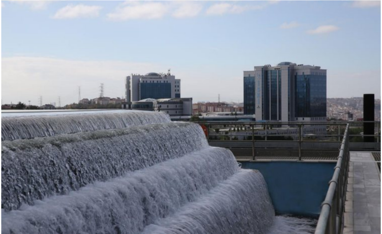
Su Arıtma Tesisi
