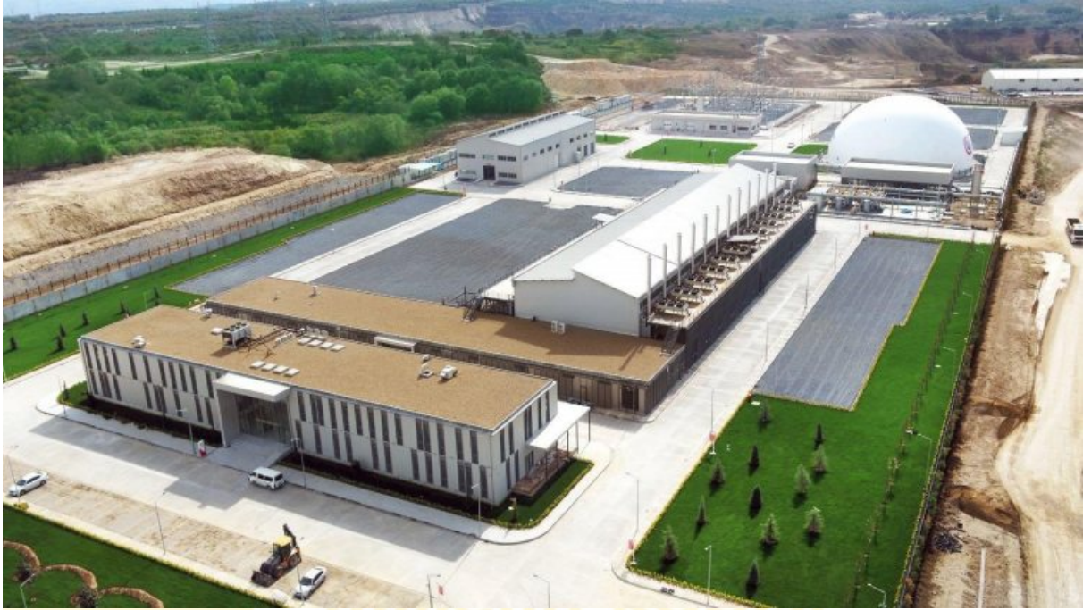
Çöp Gazından Elektrik Üretim Tesisi
