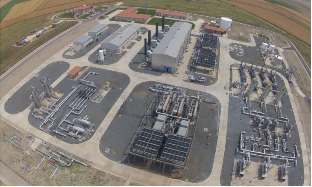
Silivri Doğalgaz Depolama Tesisi
