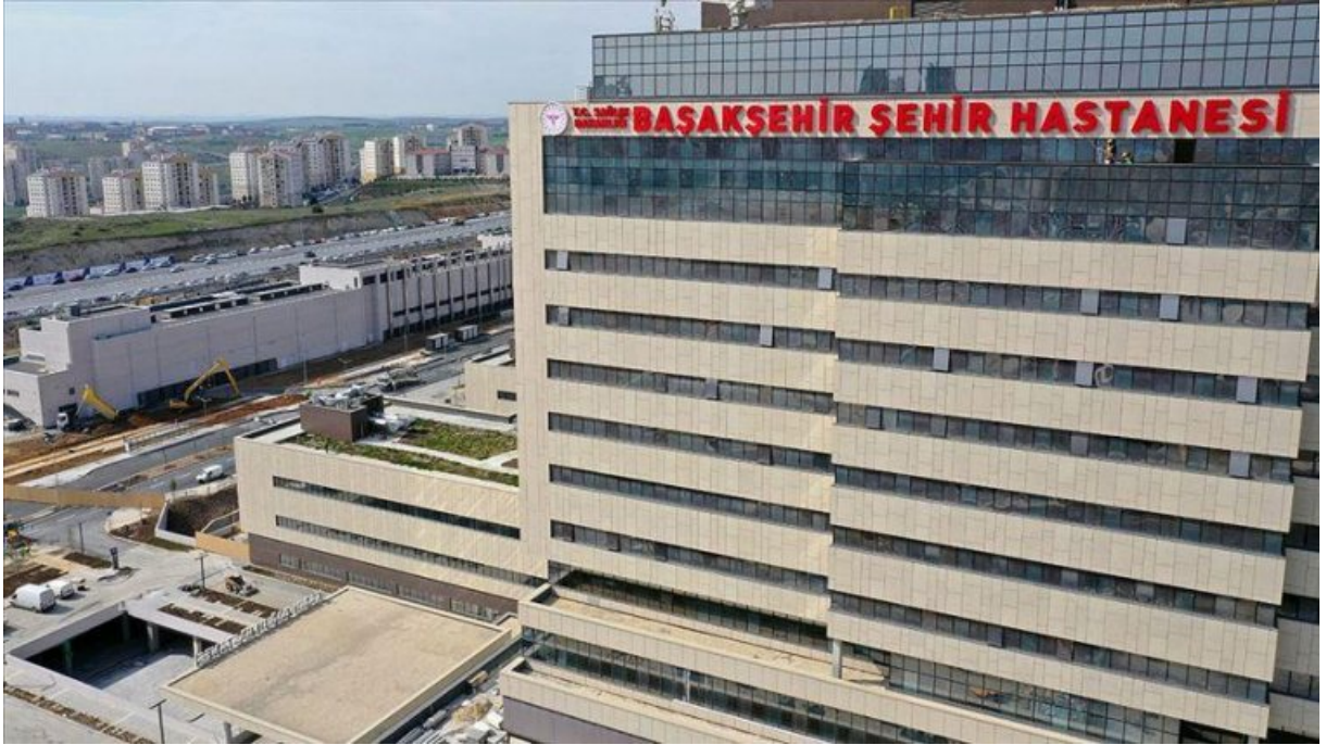
Başakşehir Şehir Hastanesi
