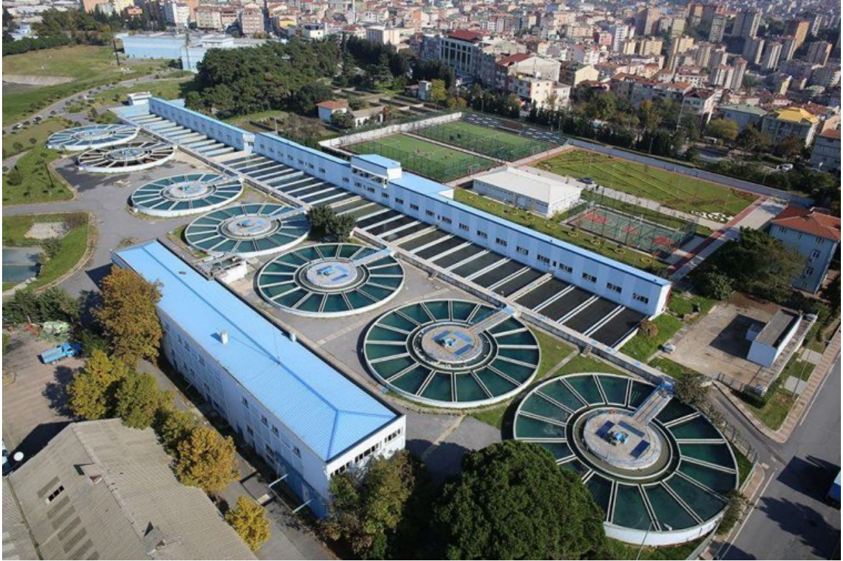
Atık Su Arıtma Tesisi
